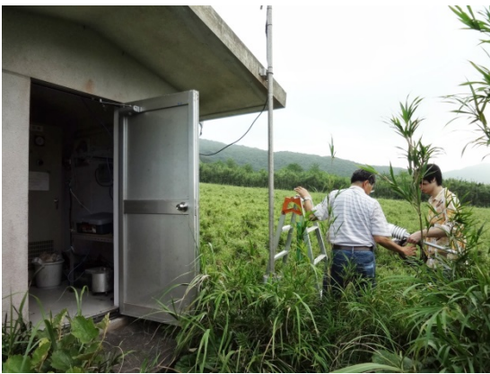
＜気象センサー取り付け作業中
